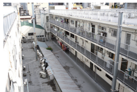
岡ビルの屋上から住居部分を眺めてみる
